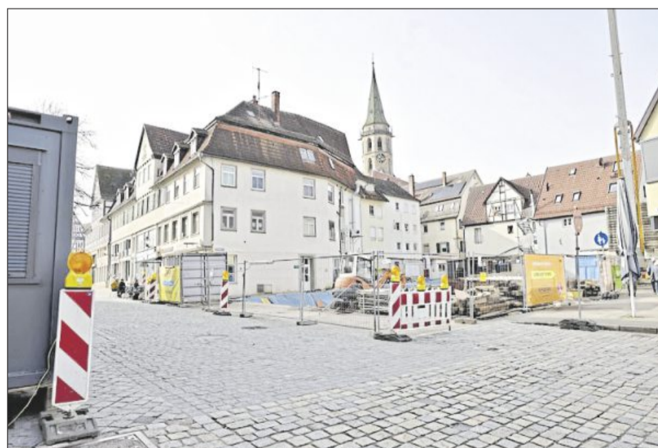
Die Großbaustelle am Marktplatz bedeutet Stress für Anlieger.
