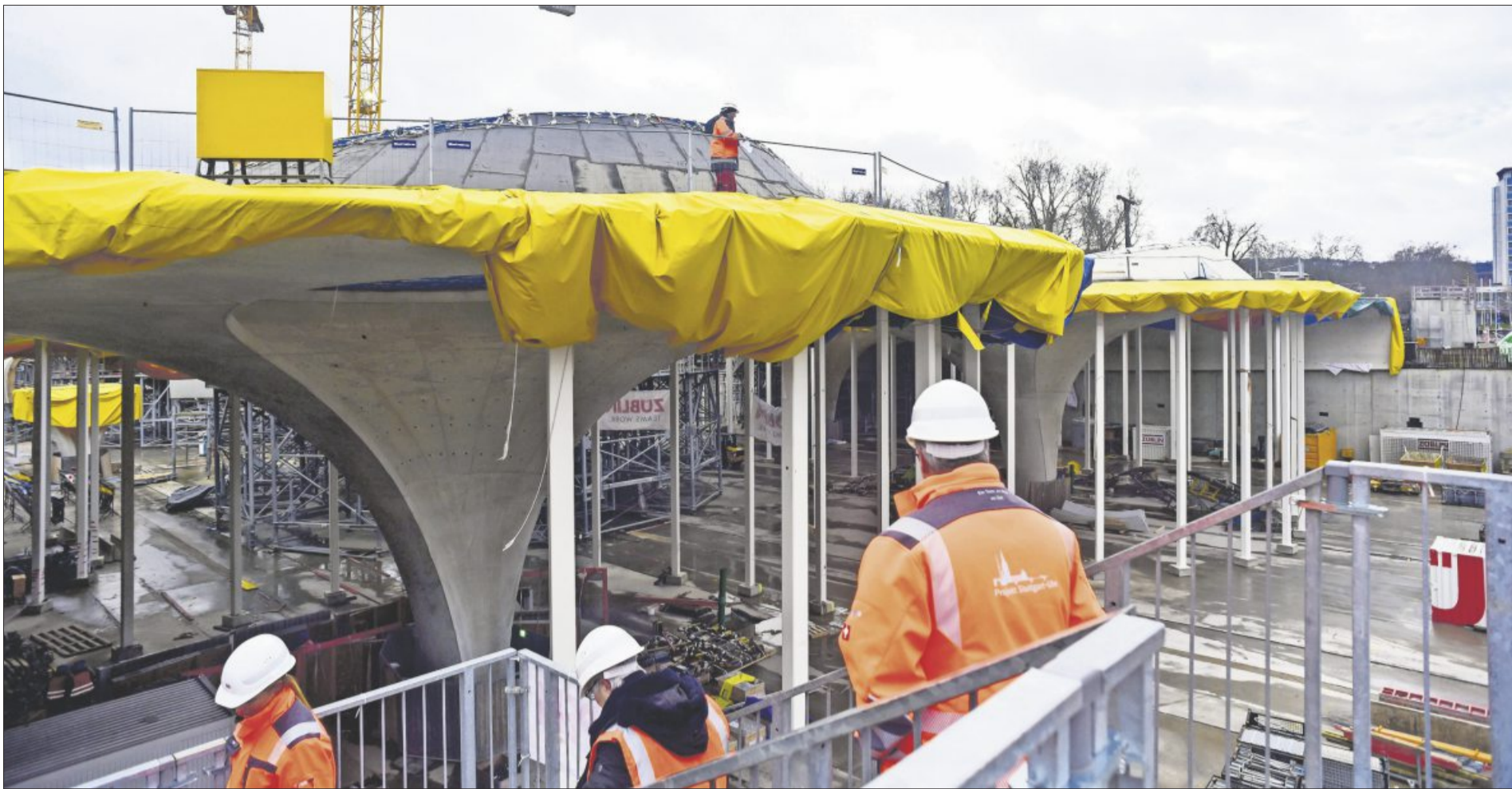
Die Arbeiten auf der S-21-Baustelle in Stuttgart gehen voran. In vier Jahren sollen die ersten Züge in den neuen Tiefbahnhof einfahren.
