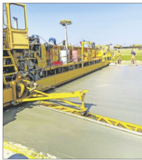
Betonieren mit Spezialmaschine auf beachtlicher Breite der Startbahn
