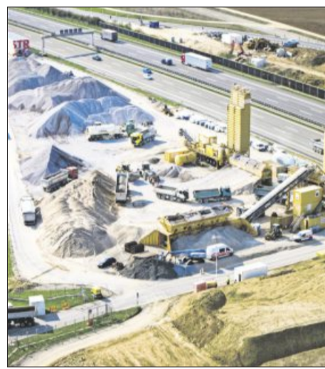
Direkt an der A 8 ist für die Dauer der Bauarbeiten ein Betonwerk eingerichtet.
