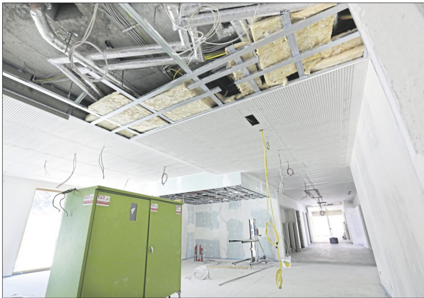
Sollte eigentlich schon bezugsfertig sein, sieht aber immer noch wie eine Baustelle aus: der neue Bewegungskindergarten.
